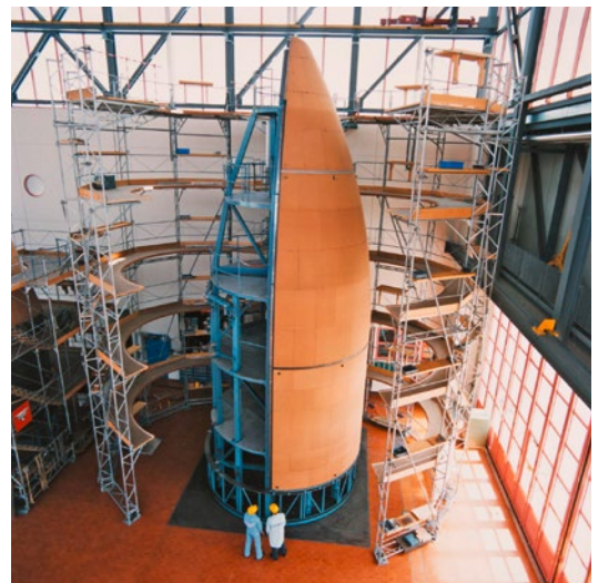
Construction de missiles à Emmen, 1992
