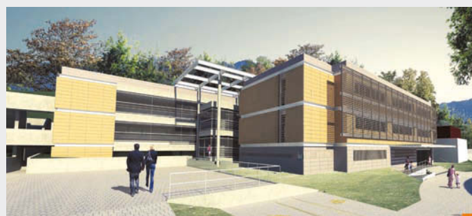
Novo prédio da ESB-RJ
